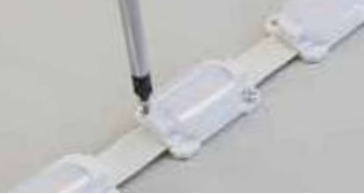
取付ネジによる固定
