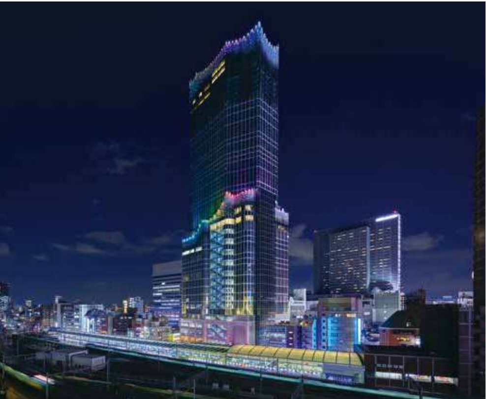
東急歌舞伎町タワー 器具：特注クロマスタフラット 外装デザイン：永山祐子建築設計 設計：久米設計・東急設計コンサルタント設計共同企業体 照明設計：ICE 都市環境照明研究所 撮影：鈴木 文人
