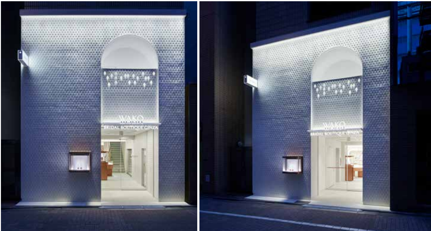
和光ブライダルブティックギンザ 灯具：GRX02S-35K-15D インテリアデザイン：丹青社 照明デザイン：L.GROW lighting planning room Inc. LightRange 撮影：ナカサアンドパートナーズ
