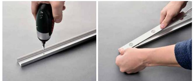
アルミケースはランプの取り付けられたカバーとベースに分割されていますので、施工面にベースを市販のΦ3mmネジで止め、その後カバーをはめ込んで固定します。
