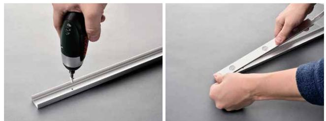
アルミケースはランプの取り付けられたカバーとベースに分割されていますので、施工面にベースを市販のΦ3mmネジで止め、その後カバーをはめ込んで固定します。
